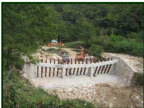
Briglia filtrante in calcestruzzo e opera in pietrame
