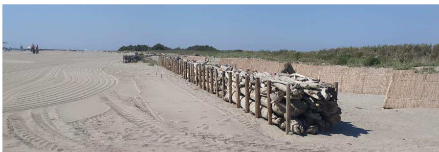
Opere frangi onda per la protezione degli apparati dunali esistenti.
