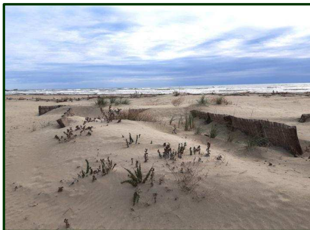
Barriere frangivento e posa specie psammofile autoctone per il ripristino dei profili dunali.
