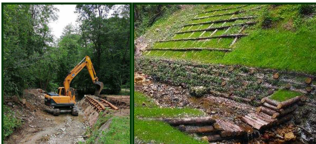
Opere trasversali e longitudinali realizzate con tecniche di ingegneria naturalistica per il consolidamento del fondo dell'alveo e difesa di sponda
