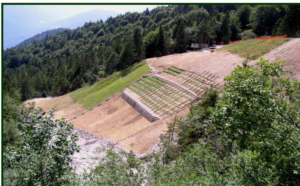
Opere di consolidamento versante in frana.
