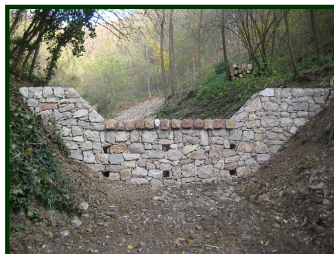
Briglia filtrante in calcestruzzo e opera in pietrame
