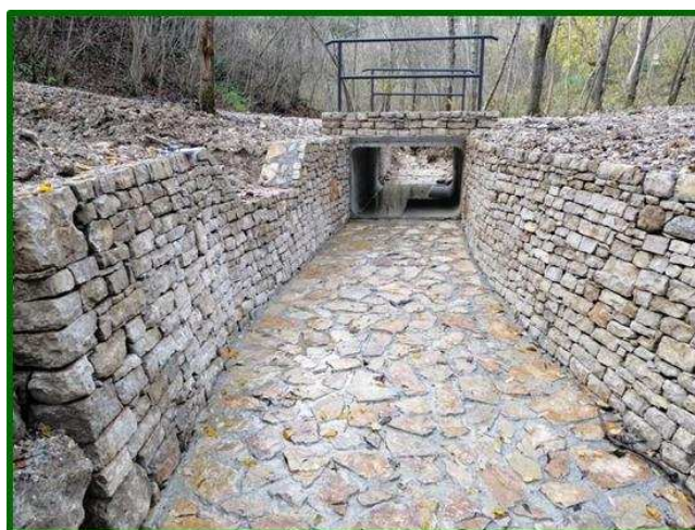
Cunettone in calcestruzzo rivestito in pietrame.
