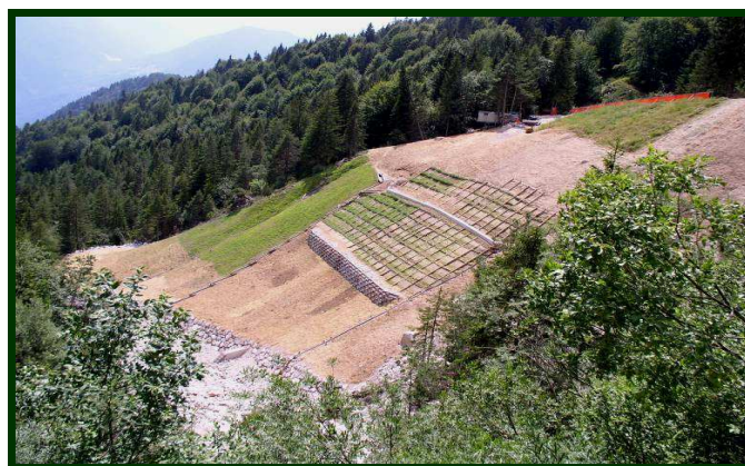
Opere di consolidamento versante in frana
