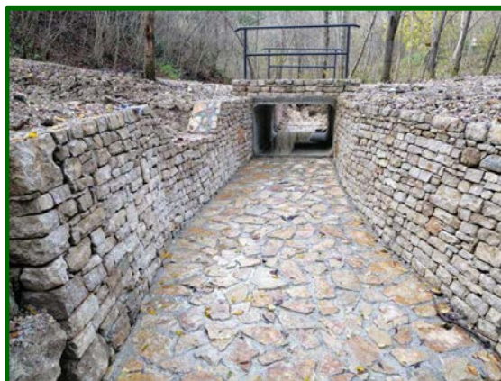
Cunettone in calcestruzzo rivestito in pietrame
